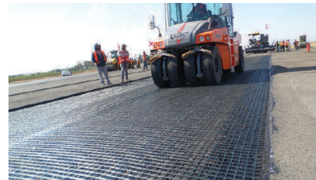
Укладка дорожной сетки МакГрид® EG в Татарстане
