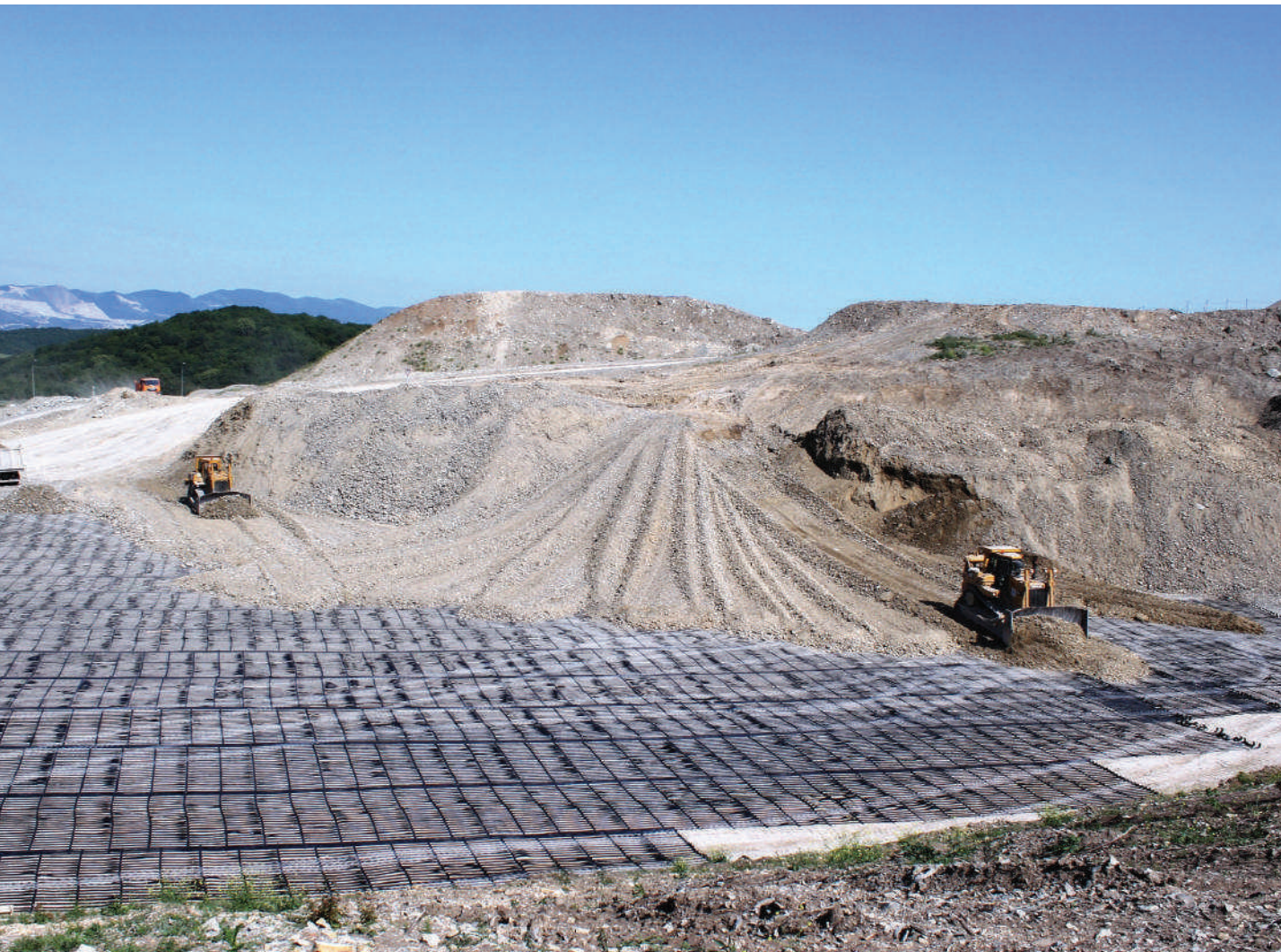
Строительство резервуарного парка КТК-2, Новороссийск
