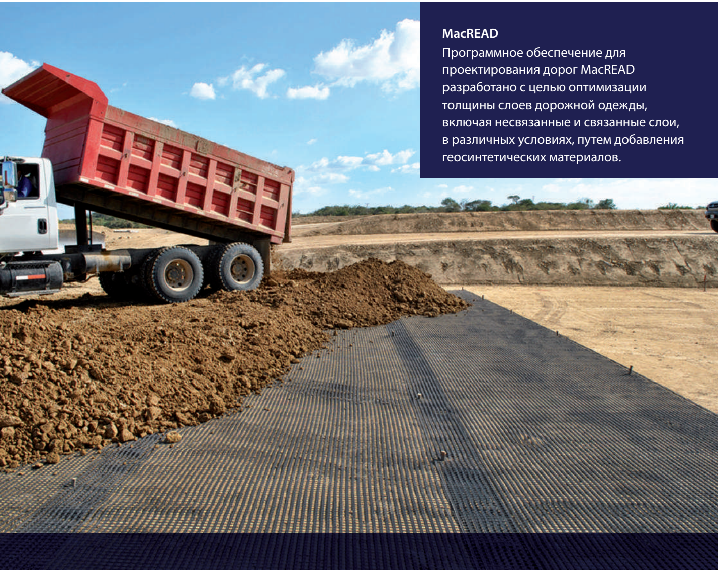
Укладка дорожной сетки МакГрид® EG в Татарстане
