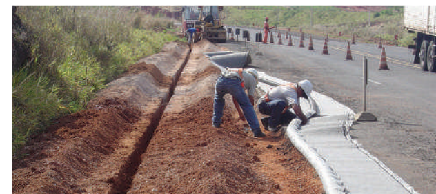
Решения для дорог и дорожного покрытия
