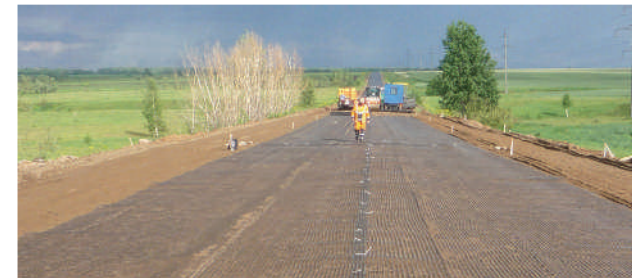
Укладка дорожной сетки МакГрид® EG в Татарстане
