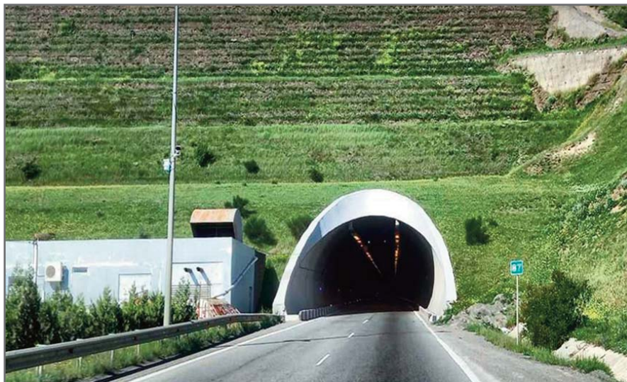
Рис. 4. Армогрунтовое сооружение на основе системы «Зеленый Террамеш» (Грузия)
