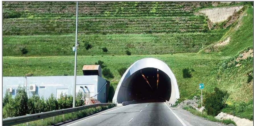
Рис. 4. Армогрунтовое сооружение на основе системы «Зеленый Террамеш» (Грузия)
