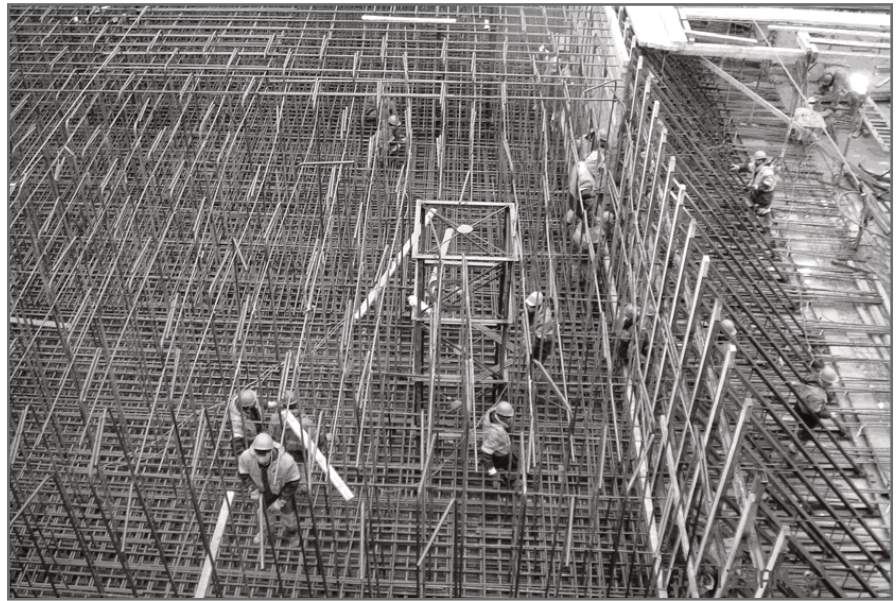
Рис. 6. Установка арматуры для заливки ростверковой плиты толщиной 4,5 м [19]
