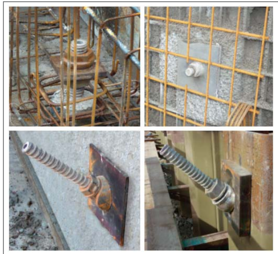
Рис. 7. Варианты головных конструкций [8]
