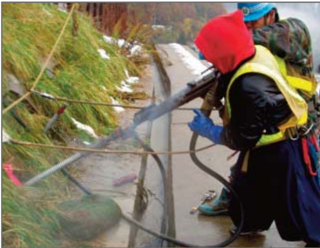
Рис. 9. Использование ручного пневматического перфоратора для бурения с помощью буроинъекционных штанг малых типоразмеров (с внутренними/наружными диаметрами от 30/16 до 40/16) [8]
