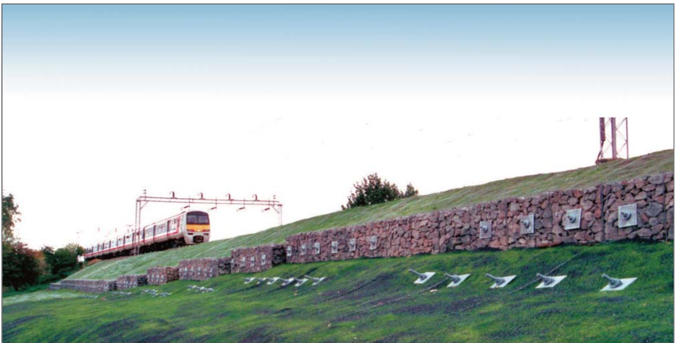
Рис. 14. Укрепление железнодорожной насыпи стальными сетками, габионами и грунтовыми буроинъекционными анкерами типа «ТИТАН»
