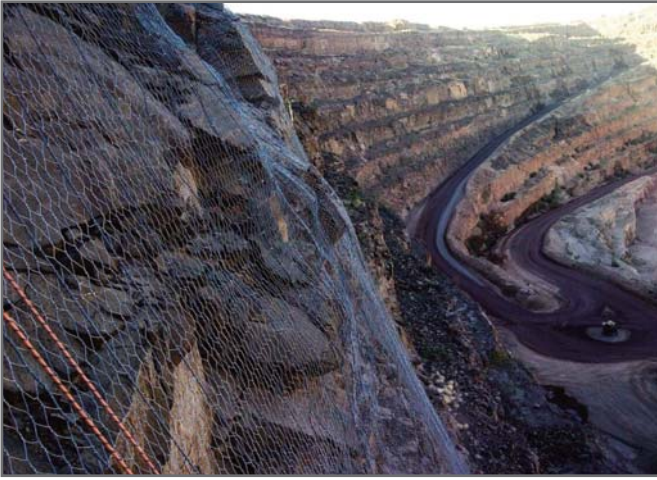
Рис. 4. Защита бортов карьера системой «Стилгрид®»
