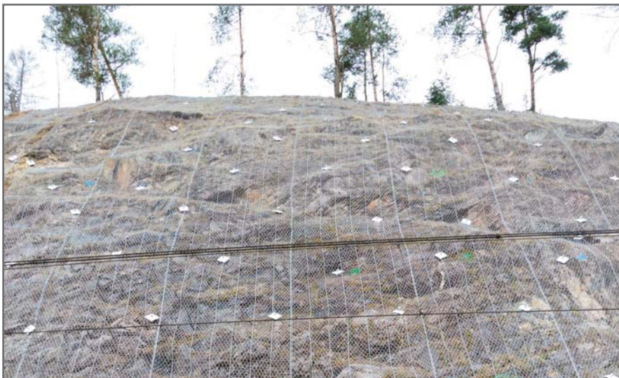
Рис. 2. Склон, защищенный системой «Стилгريد®»
