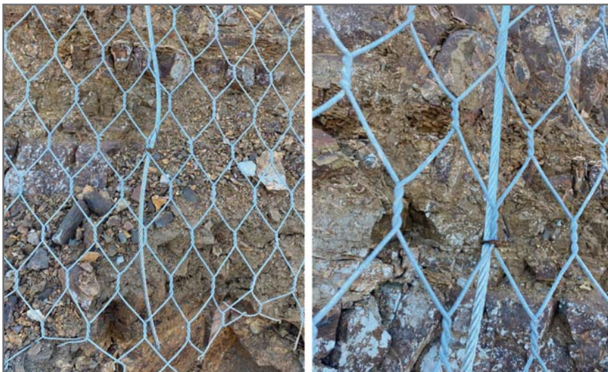
Рис. 8. В случае этих подделок тросы прикручены к сетке проволокой
