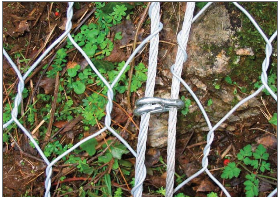
Рис. 1. В системе «Стилгрид®» тросы интегрированы в скрутки сетки
