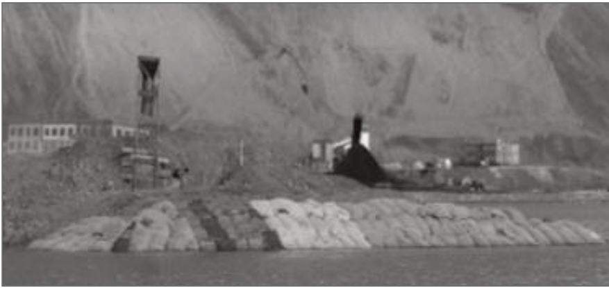
Рис. 8. Использование геомешков для уменьшения береговой эрозии было протестировано в месте расположения шахты «Свеагрува» («Свеа») на Шпицбергене [31]
