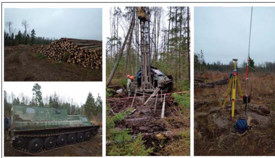
Рис. 4. Подготовка территории для строительства газоперерабатывающего комплекса вблизи поселка Усть-Луга
