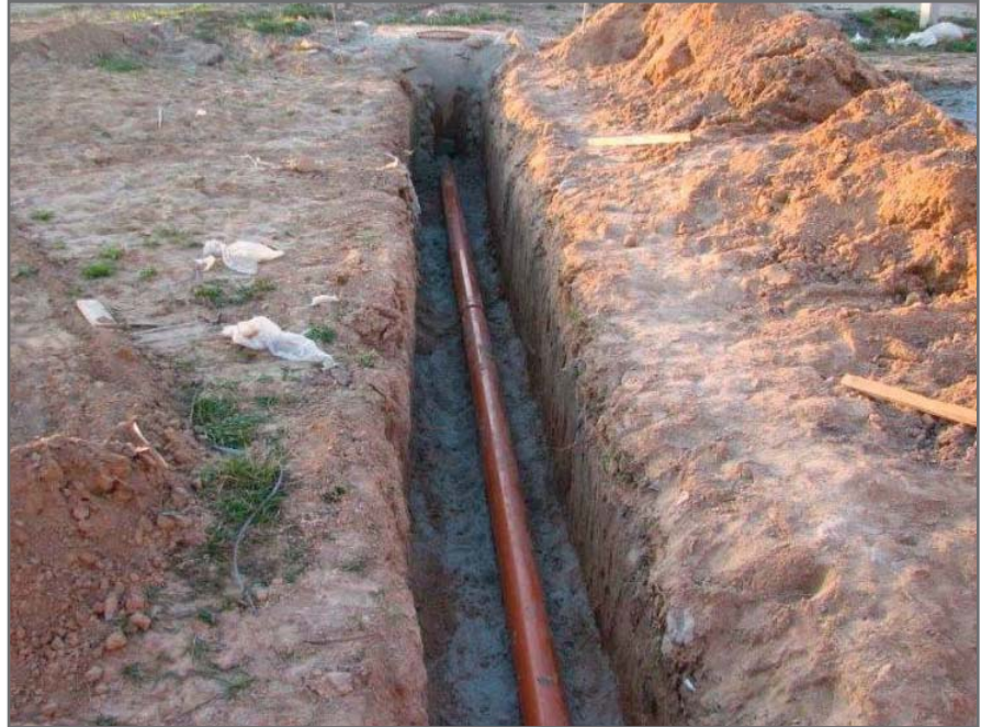
Рис. 1. Канализационные трубы укладывают в вырытые траншеи, которые потом засыпают [1]
