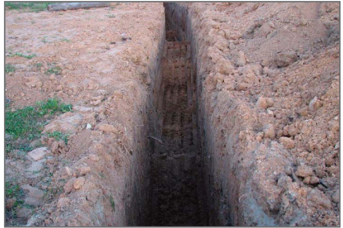
Рис. 3. При строительстве канализационного сооружения важна устойчивость стенок траншеи, выкопанной для укладки труб [1]
