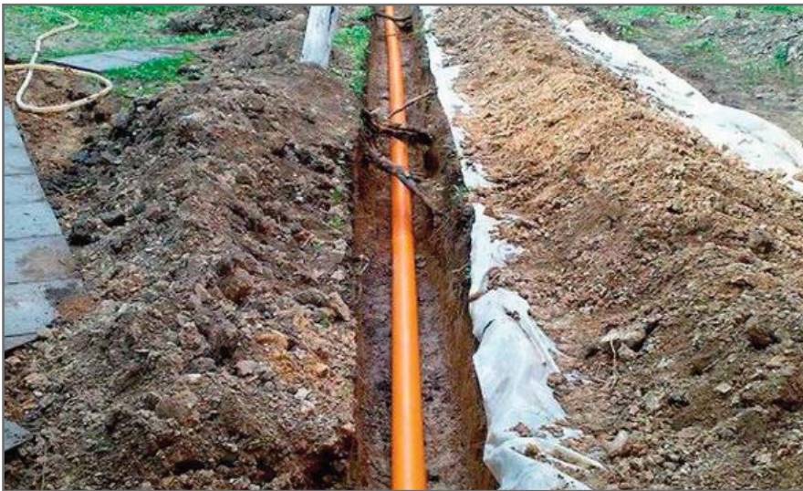
Рис. 6. Трасса канализационного сооружения может пересекать трассы других инженерных сетей, продуктопроводов, основания зданий, корни деревьев и т. д. [2]
