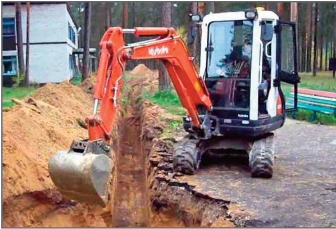
Рис. 2. Важно выяснить, есть ли возможность проводить выемку грунта такой наиболее распространенной землеройной машиной, как экскаватор (на фото – мини-экскаватор), или нет [2]
