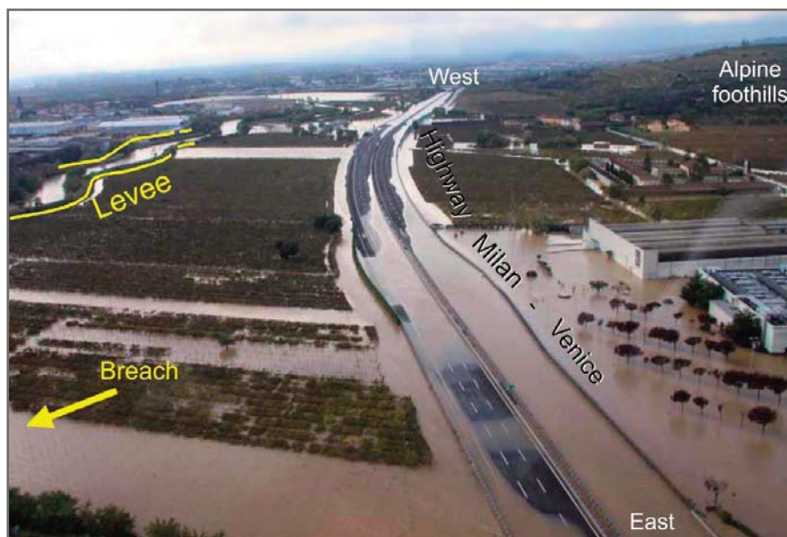
Рис. 1. Автомагистраль Милан – Венеция, затопленная 1 ноября 2010 года после разрушения земляной дамбы (выделенной желтой линией), идущей вдоль берега ближайшей реки [1]
