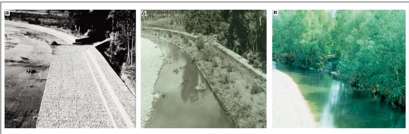
Рис. 8. Берегоукрепление с помощью комбинации матрацевидных и обычных габионных конструкций: а – строительство берегоукрепительной системы; б – начало образования растительного покрова на ней; в – выросший на ней лес
