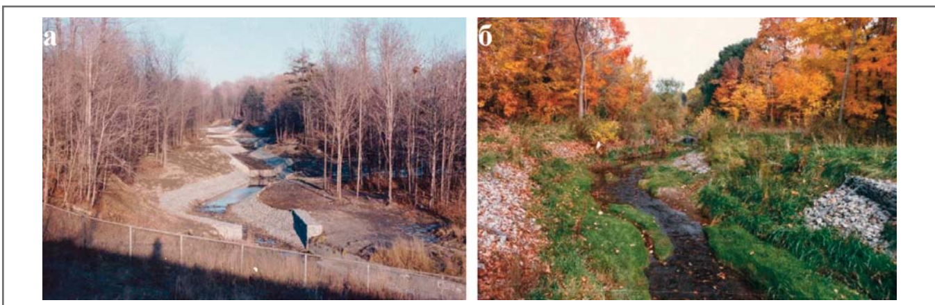
Рис. 9. Берегоукрепление с помощью комбинации матрацевидных и обычных габионных конструкций: а – строительство берегоукрепительной системы; б – образовавшийся на ней растительный покров
