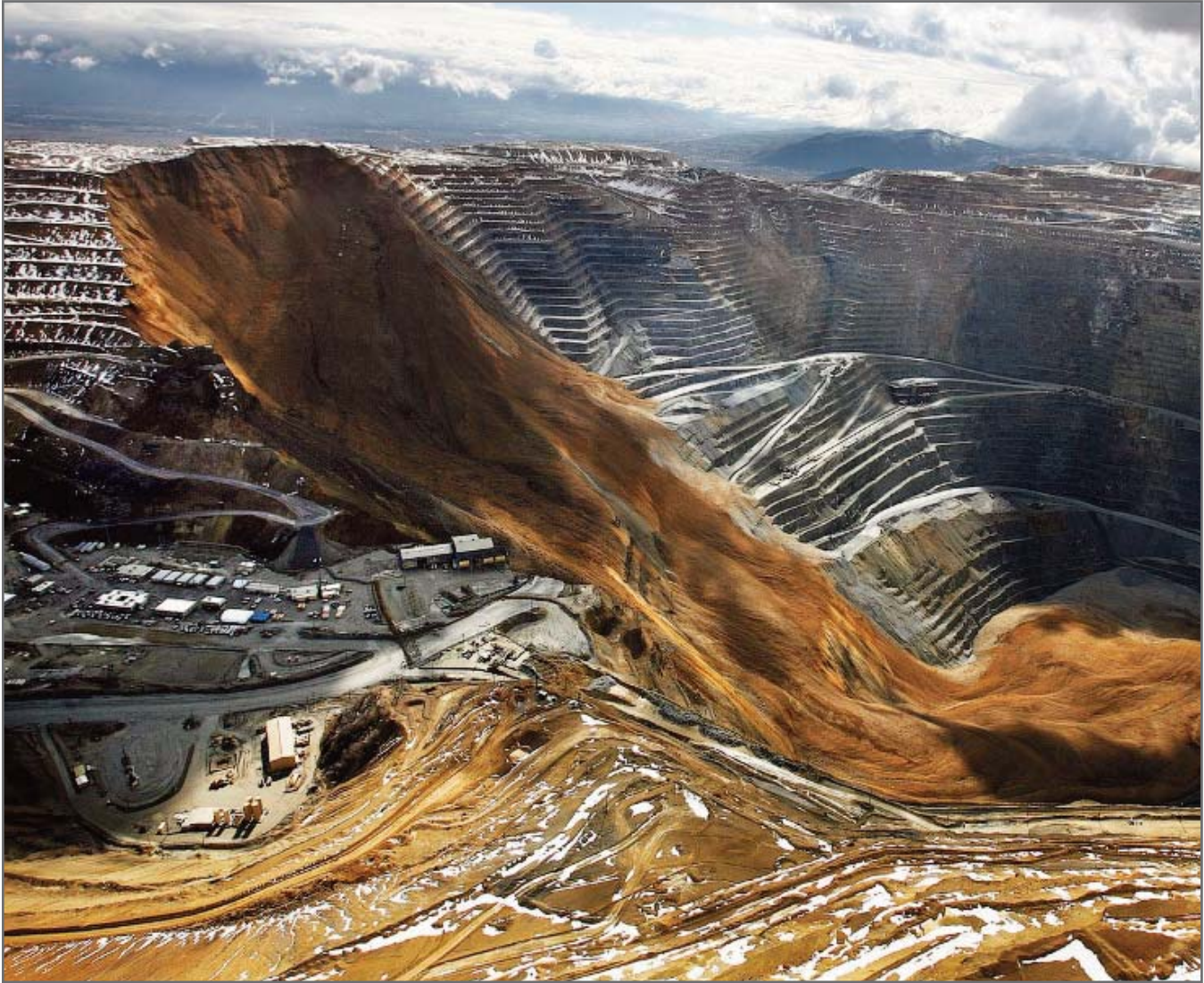
Рис. 4. Гигантский оползень, сошедший 10 апреля 2013 года с борта крупнейшего карьера по добыче медной руды «Бингем» в США [6]
