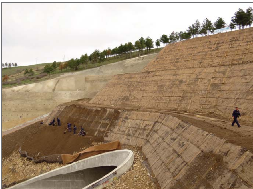
Система армирования грунта Зеленый Террамеш, Грузия
