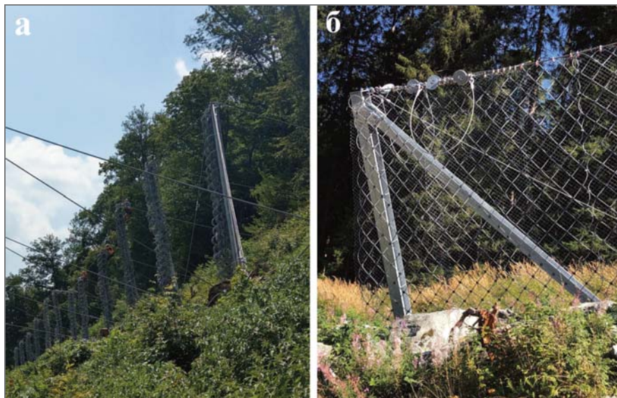
Рис. 1. Противокаменный барьер, смонтированный в соответствии с четкими и простыми инструкциями (а); модификация крайней секции барьера без боковых анкеров, но с диагональной стойкой в качестве замены (б)
