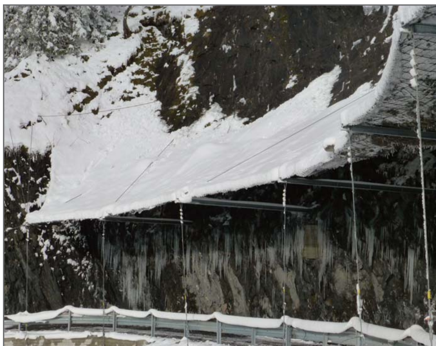
Рис. 3. Противокамнепадный барьер под воздействием снеговой нагрузки
