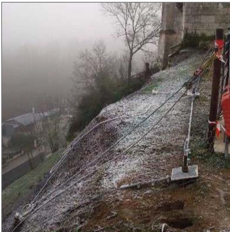
Рис. 2. Анкерные болты для закрепления верхнего несущего троса сетчатой противокампедной завесы
